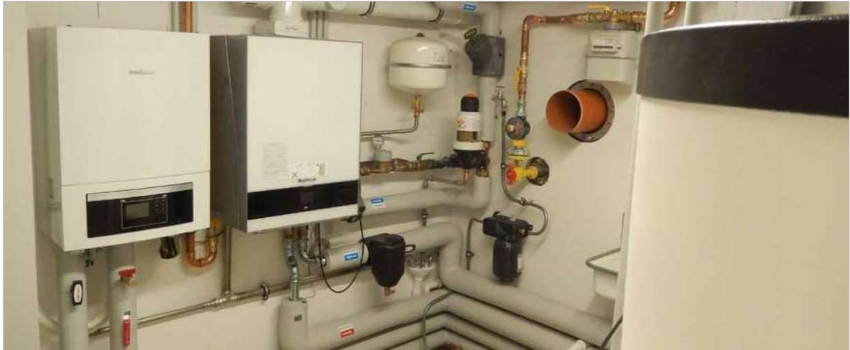
Abbildung 108 Gebäudezentrale mit Wärmepumpe und Gasbrennwerttechnik als Spitzenkessel
