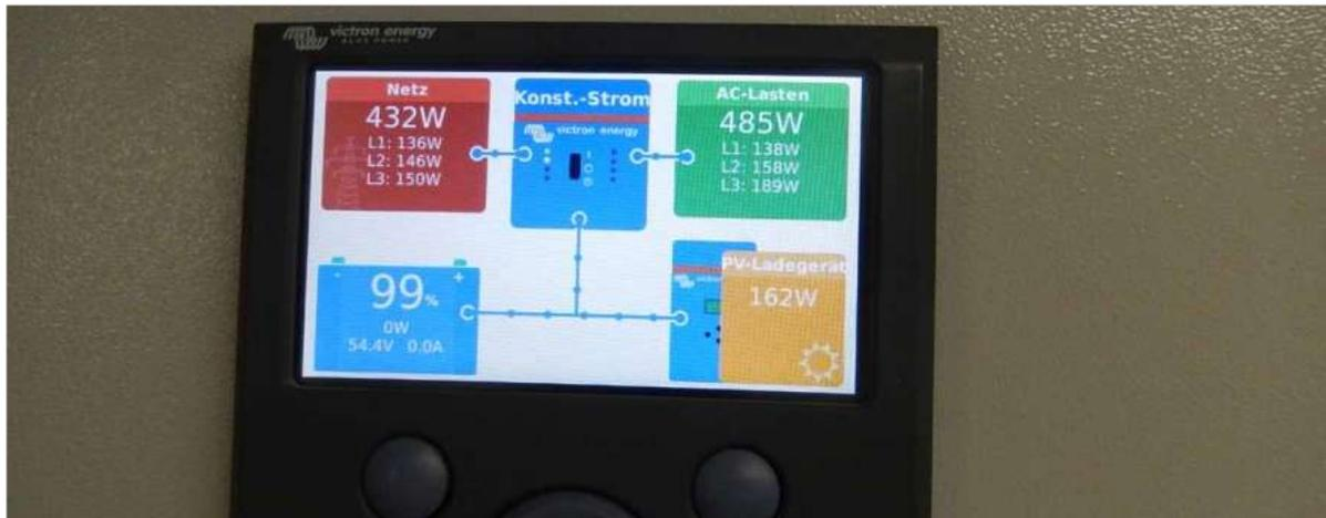
Abbildung 110 Display der Regelung mit der Darstellung der PV-Erträge und des Strombedarfs
