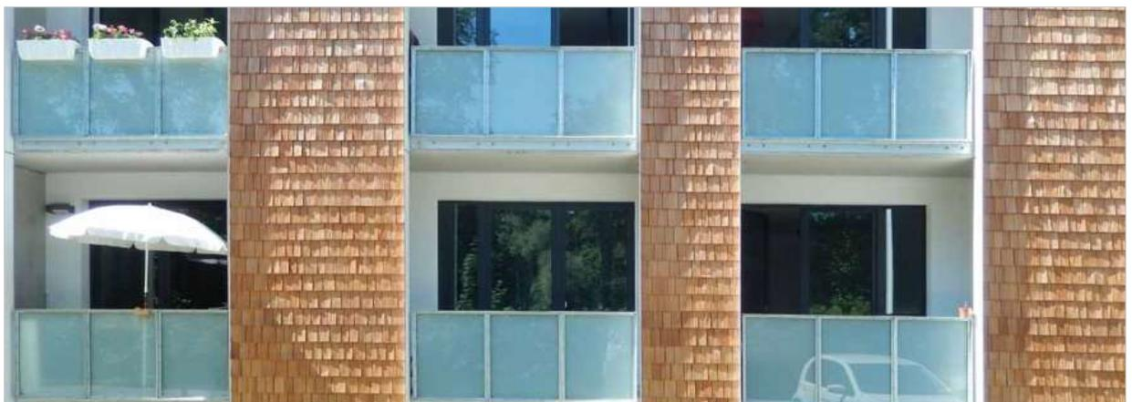
Abbildung 107 Fassadendetail der Holzbekleidung auf der Balkonseite
