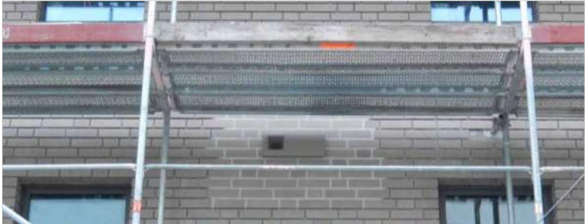
Abbildung 86 Fassadendetail mit Außenluftdurchlass der wohnungszentralen Lüftungsanlagen
