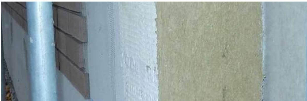
Abbildung 87 Aufbau des Wärmedämmverbundsystems mit Riemchenbekleidung
